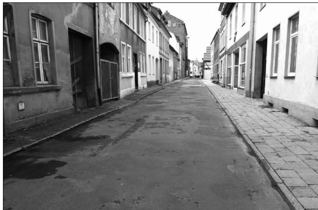
Ansicht des dringend sanierungsbedürftigen Bestandes
