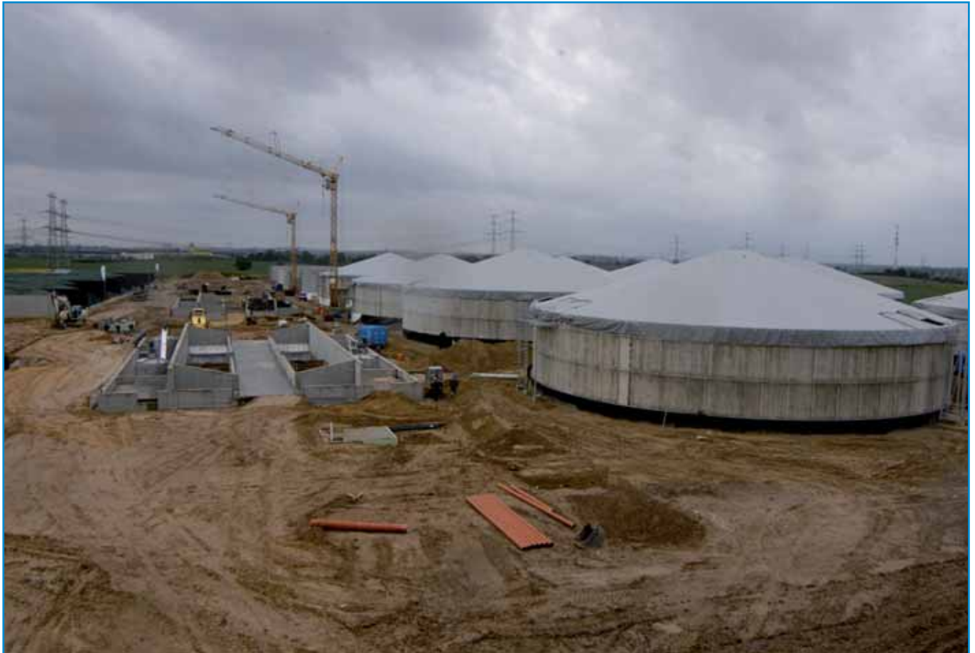
Baustelle NAWARO BioEnergie Park Güstrow, Oktober 2008
