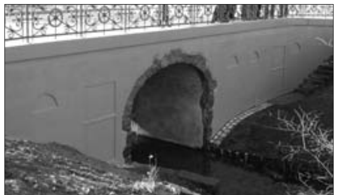
Nordansicht der Brücke nach der Sanierung
