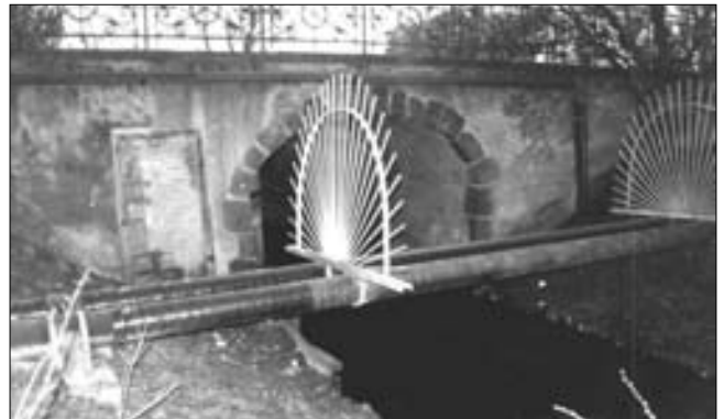
Nordansicht der Brücke vor der Sanierung
